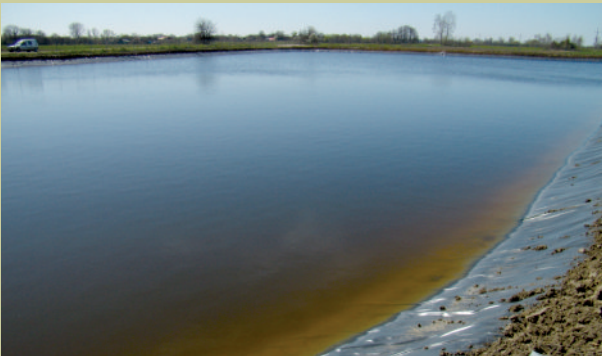
Oczyszczalnia ścieków Nowy Korczyn 10 000 m 2 / Nowy Korczyn Waste Water Treatment Plant 10 000 m 2 / Очистное сооружение Новы-Корчин 10 000 м 2
