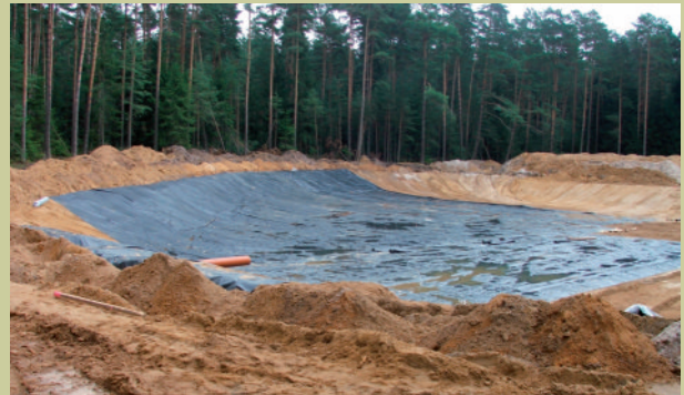
Leśne zbiorniki przeciwpożarowe okolice Leszna (jeden zbiornik ok. 4 000 m 2 ) / Forest fire-protection water basins near Leszno (one water basin approximately 4000 m 2 ) / Лесные пожарные водоемы вблизи Лешно (один водоем ок. 4 000 м 2 )
