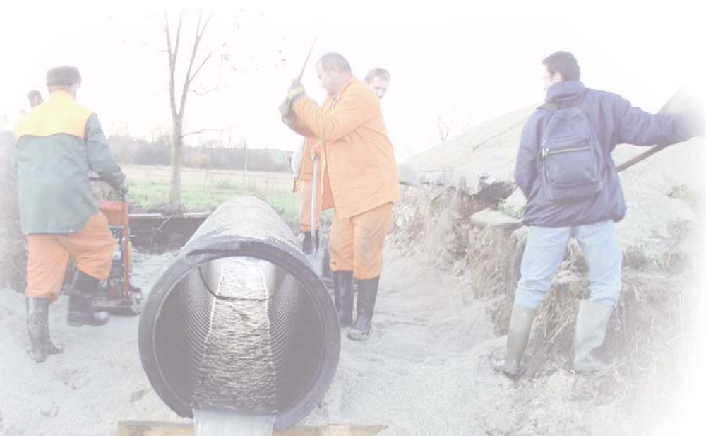
Rys. 14. Sposób kształtowania zasypki dla konstrukcji wielootworowych
